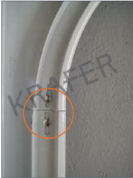
Sørg for jevne overganger til buen.
