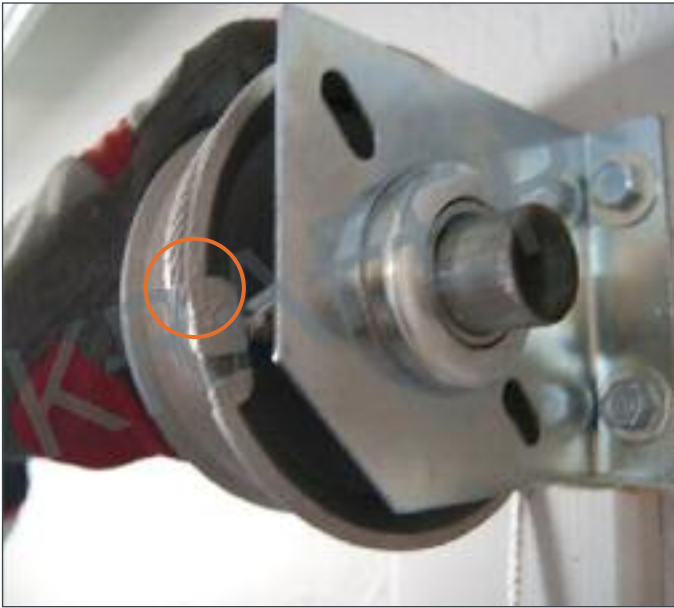
Legg på wiren i pilens retning, som vist på bildet.
