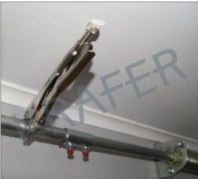
Lås torsjonsstangen med en sveisetang.
