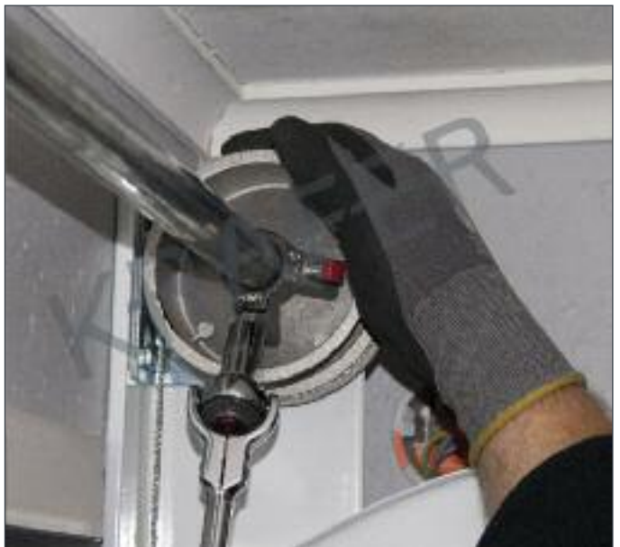
Stram wiren og skru wirehjulet godt fast til torsjonsstangen. (15 Nm)
