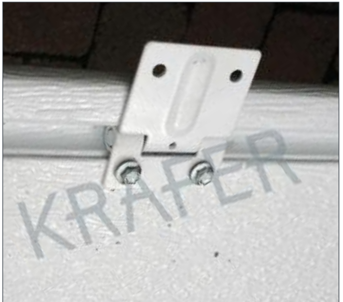
Skru fast midthengsel(er) jevnt fordelt på portelementet. Antall midthengsler varierer med portens bredde. Tell hengsler og fordel antallet.
