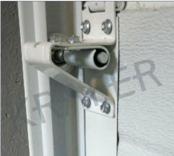
Fest deretter hjulfestet. (Hjulfestet kan med fordel settes under braketten på det nederste elementet.) Høyre og venstre er ulike. Plastforing skal sitte i ytterkant på hjulfestet.
