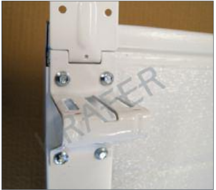
Press kantforsterker godt innpå portelement. Skru fast øvre hengsel.
