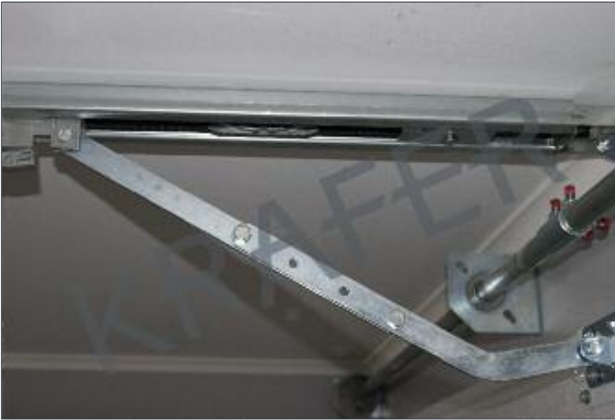
Viser trekkarmen ved overhøyde 20 - 40 cm. Nå benyttes skjøtestykket.
