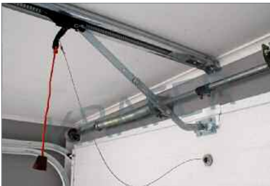
Viser trekkarmen ved overhøyde 20 - 40 cm. Nå benyttes skjøtestykket.
