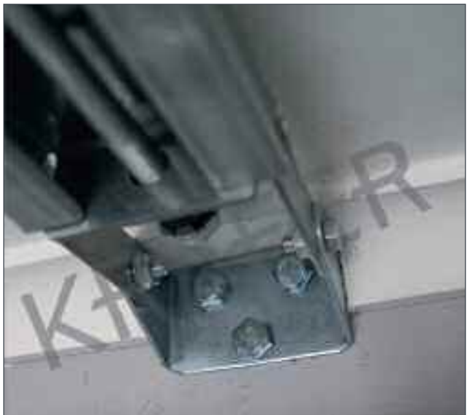
Skru festebraketter til trekkskinna som monteres over torsjonsstang. kan forflyttes sidelengs hvis det er hensiktsmessig. Må ikke sitte på midten selv om det er mest vanlig.
