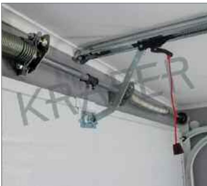
Skru fast braketter med 4 skruer for trekkarm midt på øvre portelement.
